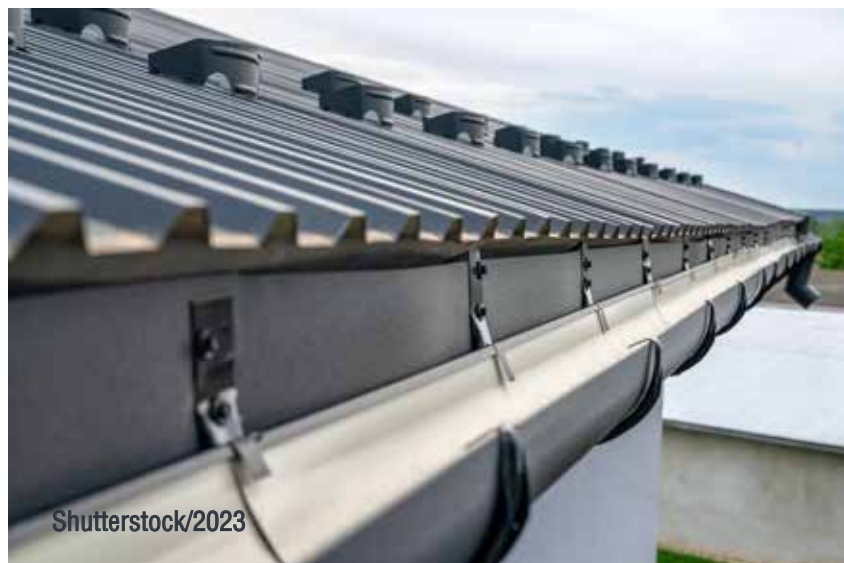
Figura 17. Canales para la recolección de agua lluvia
