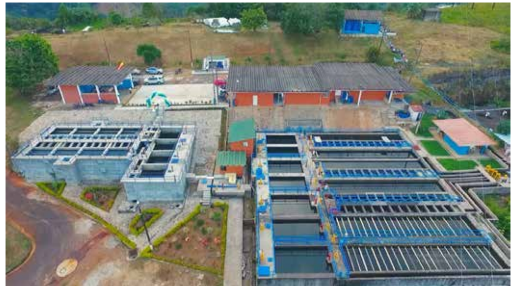
Figura 14. Planta de tratamiento Filtración en Múltiples Etapas (FIME) en acueductos rurales
